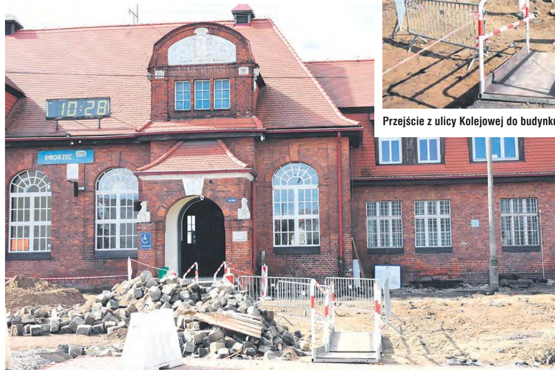
Tymczasowe rozwiązanie dojścia do dworca.
