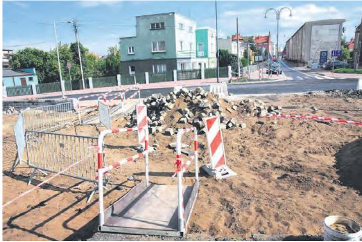
Przejście z ulicy Kolejowej do budynku dworca PKP.
