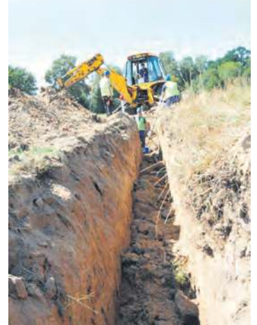
Prace nad nową siecią wodociągową trwają od połowy sierpnia.
