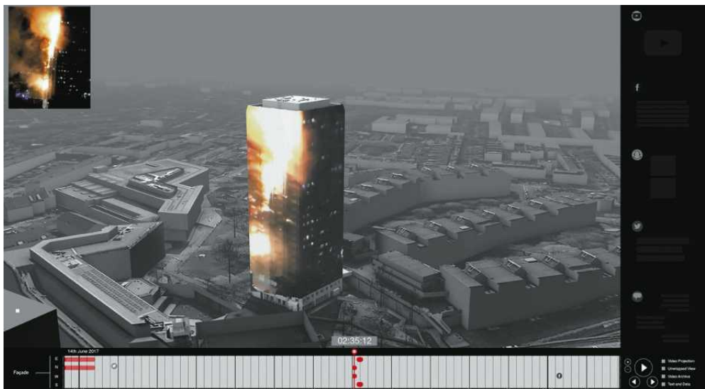
▲ Grenfell Tower, 23-piętrowy blok mieszkań komunalnych w dzielnicy Kensington w Londynie spłonął 14 czerwca 2017r. Zginęły 72 osoby.
