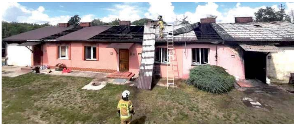
W chwili przyjazdu strażaków pożar był już w pełni rozwinięty i obejmował skrajne mieszkanie oraz całe poddasze
