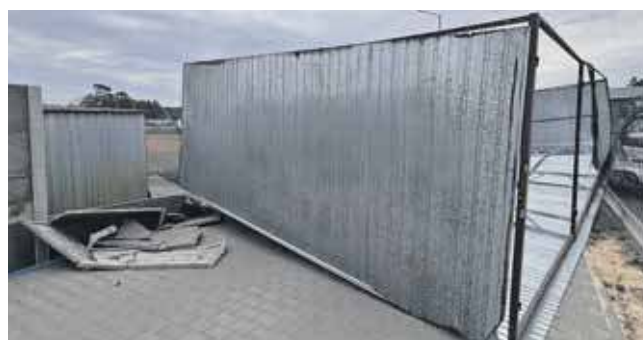
Strażacy z OSP Ożarówice przemieścili elementy blachy w bezpieczne miejsce
