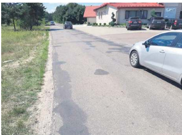
Droga Sól – Bidaczów przejdzie gruntowny remont.
