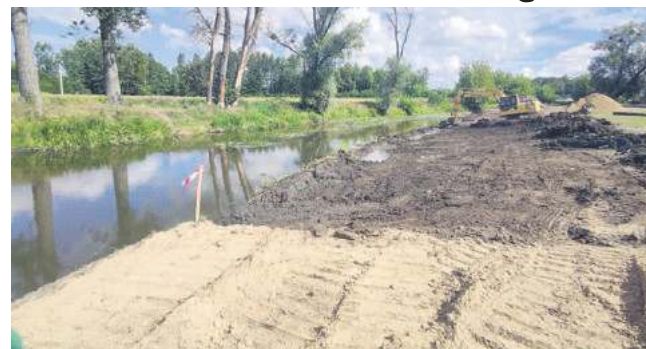
Roboty ziemne przy urządzeniu kąpieliska potrwać do końca sierpnia.
