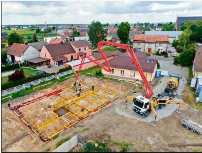
Wylano już pierwsze fundamenty pod budowę centrum.
