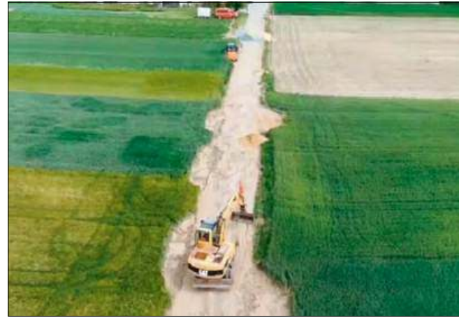
Trwają też prace przy przebudowie drogi pomiędzy Kromolowem a Zabierzowem.
