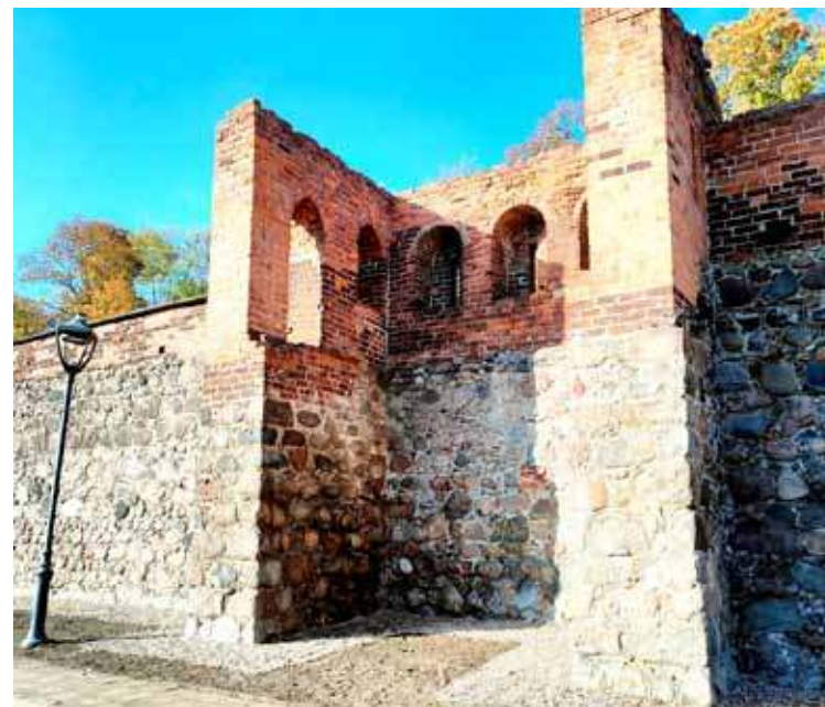
Zakończyła się odbudowa murów przy ulicy Klasztornej
