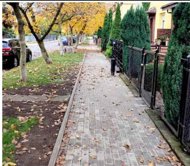
Zakończyła się inwestycja na ulicy Paderewskiego, w ramach której mieszkańcy uzyskali 400 metrów nowego chodnika
