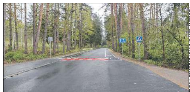
Przebudowa drogi powiatowej nr 2007W Kózki-Serpelice-Borsuki na odcinku od Serpelic do Zabuża trwała ponad rok i była jedną z najbardziej wyczekiwanych inwestycji
