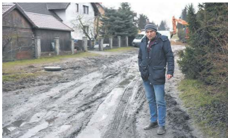
Najgorzej jest w tej części traktu, do której dojeżdża się od ulicy Prochowej. Na zdjęciu Zenon Szynewski.
