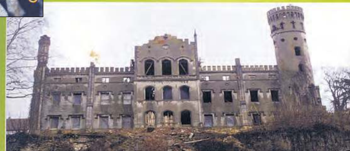
Pałac w Dobrej przed renowacją
