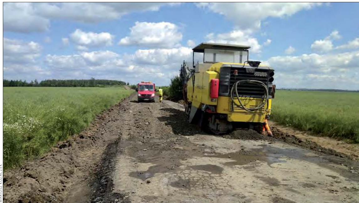
Ruszyły prace na drodze między Skrzypcem i Trzebiną
