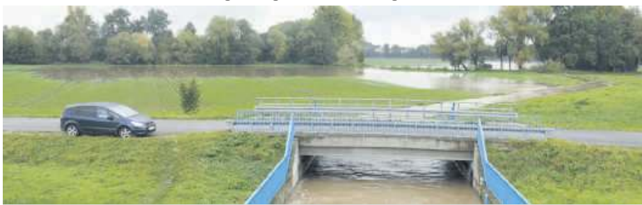
Chociaż zbiornik przejął napór wody, to i tak pola poniżej zostały częściowo zalane
