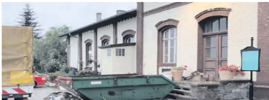
Trwa remont świetlicy wiejskiej w Boreczku
