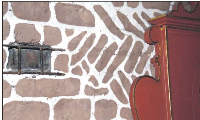
Za kratką znajduje się kamień z Ziemi Świętej obok specyficzne ułożenie cegieł
