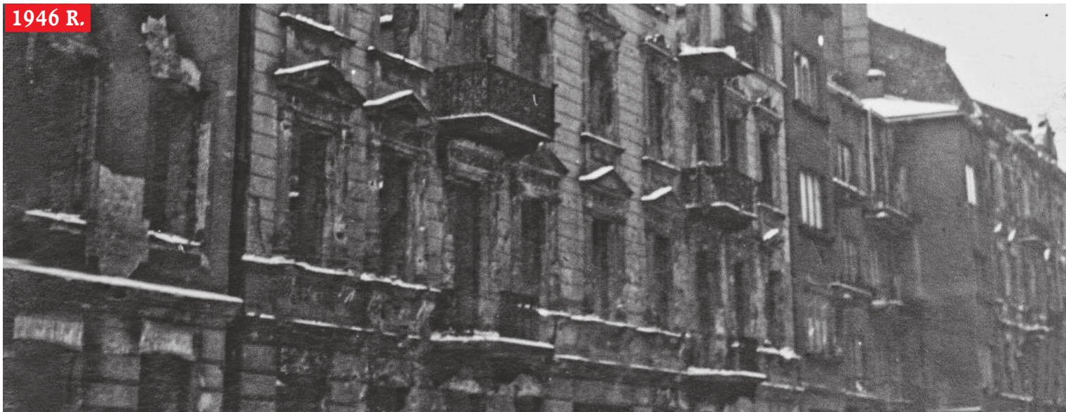
Kamienica przy ul. Pańskiej 97 zburzona w 1946 r. Akta BOS. Zbiory Archiwum Państwowego w Warszawie | fot. Tomasz Hamrat/Gazeta Polska
