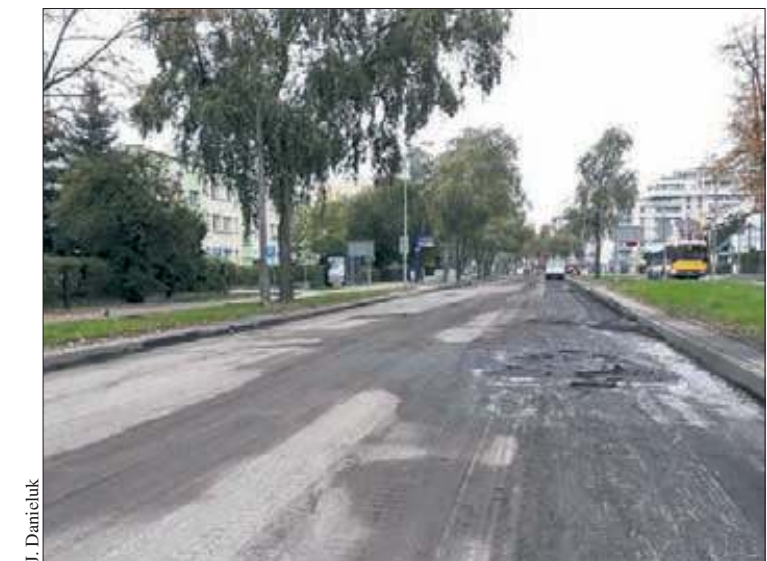
Od ubiegłego tygodnia fragment Al. Jachowicza został zamknięty dla ruchu. Prace potrwać – według planów – do końca listopada
