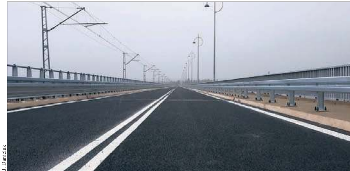
Od tygodnia możemy już przejechać wyremontowanym mostem Legionów Józefa Piłsudskiego
