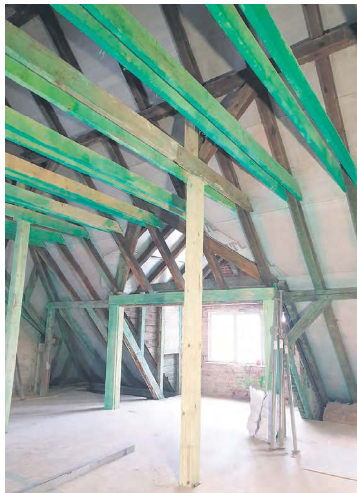
Najgorsze prace związane z rozbiórką i porządkowaniem ekipa ma za sobą.
