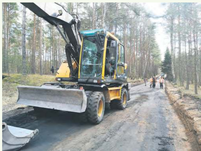
Do Łosin będzie prowadziła nowa, asfaltowa droga.
