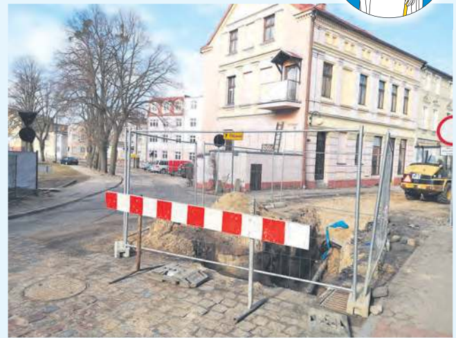
Z ruchu wyłączona została część ul. Chojnickiej. Objazd wyznaczono przez ul. Gabrychów.
