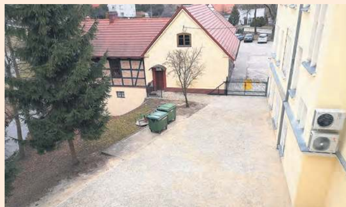
Szyb windy został wybudowany z tyłu budynku urzędu, a plac wokół zyskał nową nawierzchnię z kostki granitowej.
