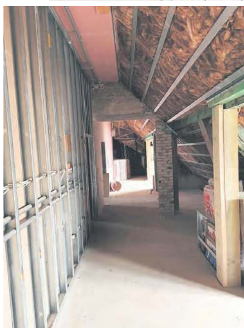
Korytarz ze ściankami działowymi.
