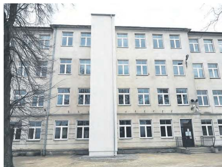
Winda w Szkole Podstawowej nr 2. Widok z zewnątrz, od strony boiska.
