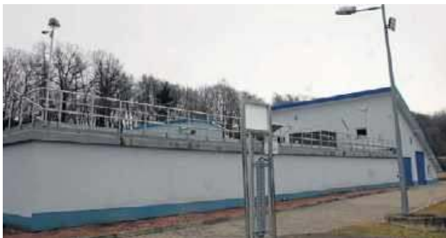
Zmodernizowana oczyszczalnia ścieków w Nowym Żmigrodzie
