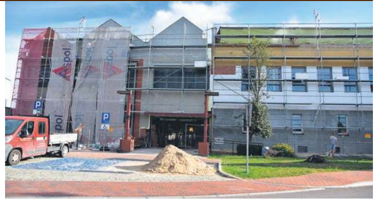
Aktualnie ocieplana jest frontowa ściana TOK-u.
