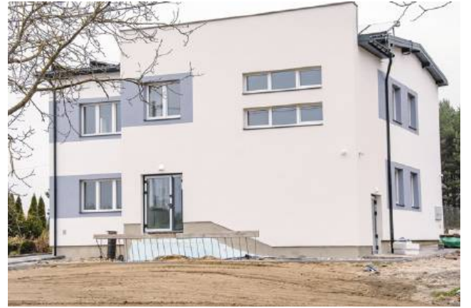
Budynek po byłym ośrodku zdrowia.
