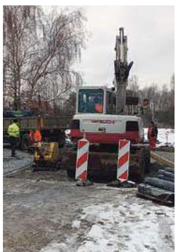
Przebudowa dróg gminnych ul. Jesionowej i Akacjiowej oraz Poziomkowej i Jagodowej w Wołowie
