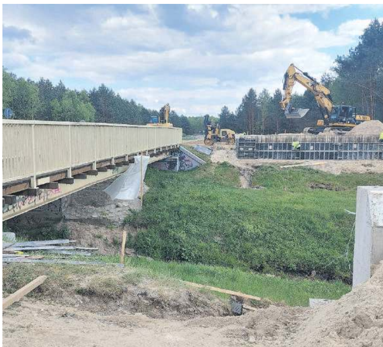
Trwają wstępne prace przy budowie nowego mostu na Jodłówce
