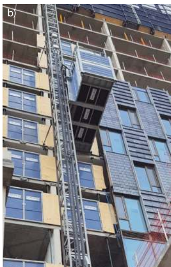
Fot. 1. Dźwigi towarowo – osobowe zewnętrzne firmy GEDA
