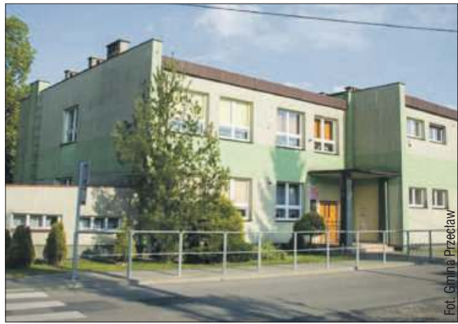
Budynek Szkoły Podstawowej w Jamach zostanie zmodernizowany.
