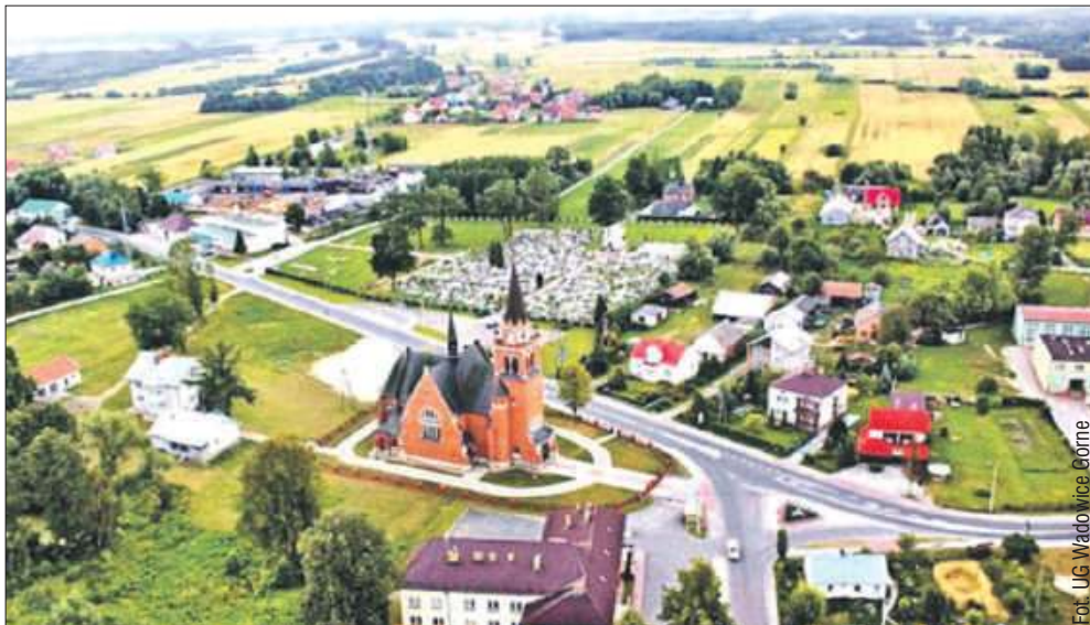
Na terenie Wadowic Górnych ma stanąć zbiornik na wodę czystą, który ma ją gromadzić na wypadek większego zużycia i być gwarancją ciągłości dostaw.
