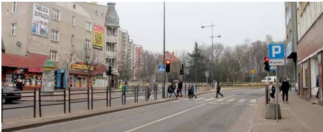
Ze środków centralnych w 80% sfinansowano m.in. przebudowę przejścia na ul. Wyszyńskiego
