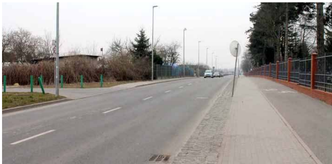
Z tego miejsca odległość od najbliższego przejścia dla pieszych jest spora, co sygnalizują mieszkańcy
