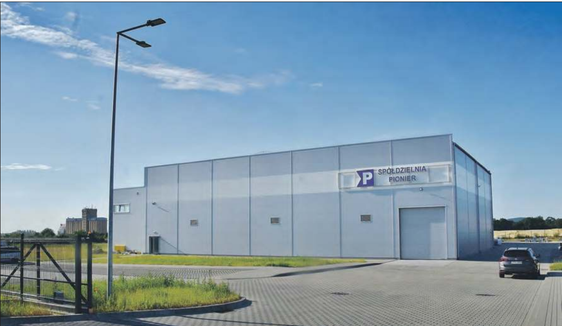
Jednym z pozytywnych przykładów działań biznesowych jest rozbudowa zakładu spółdzielni Pionier w Prudniku. Firma przenosi się ze śródmieścia do nowej hali przy ul. Przemysłowej, dając nowe możliwości rozwoju zakładu.
