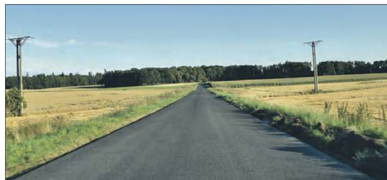
Nowa nawierzchnia na nyskim odcinku drogi powiatowej między Ścinawą a lasem
