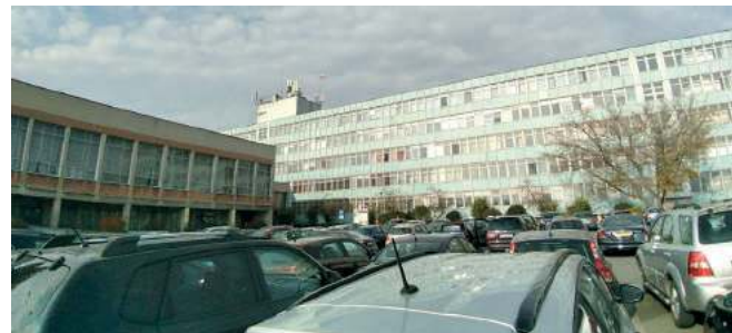
Obecny widok biurowca wraz z salą widowiskową i stołówką
