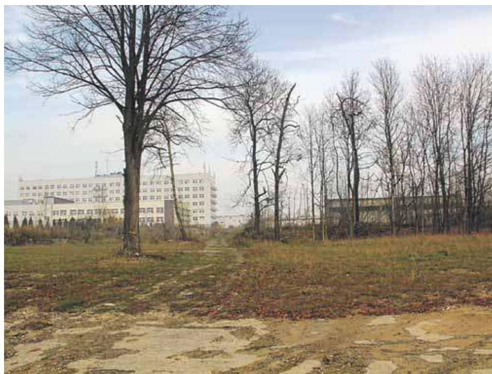
Zniknął już budynek oddziału dziecięcego, 2 hotele dla pielęgniarek, hala garażowa pogotowia, dyżurka pogotowia, 5 budynków magazynowych i 2 podziemne zbiorniki na paliwa. W sumie ponad 6 tys. metrów kw. powierzchni użytkowej.
