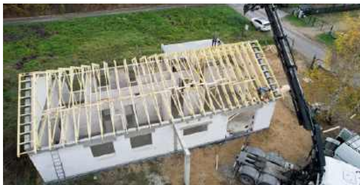
🔧 Prefabrykowane więzary dachowe montuje się w ciągu jednego dnia, ale ich produkcję trzeba zaplanować dużo wcześniej. T. RYBARCZYK
