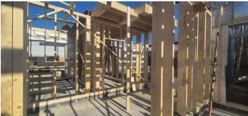
📍 Kluczowym elementem kanadyjczyka jest drewniany szkielet, który wypełnia się szczelnie wełną mineralną i ostonia wybraną okładziną. JAF POLSKA, TEKUM
