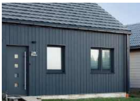
Włókno-cementowe deski elewacyjne dostępne są w wersji do montażu na zakładkę lub na pióro-wpust. CEDRAL
