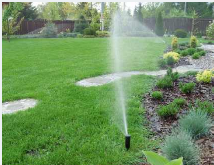
Do podlewania trawnika wykorzystuje się wynurzalny zraszacz rotacyjny.
