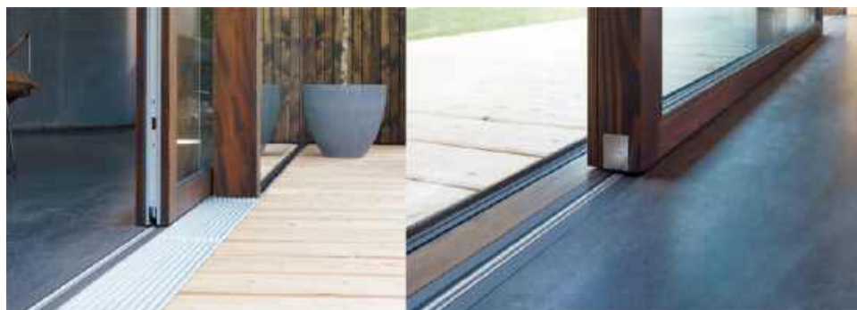
Próg drewniano-aluminiowych drzwi przesuwnych ma wysokość 0 mm, co znaczy, że jest całkowicie zlicowany z podłogą. SIEGENIA
