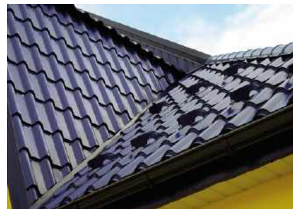
📍 Blachodachówka jest przettłaczana tak, aby wyglądała podobnie do dachówki. BP2
