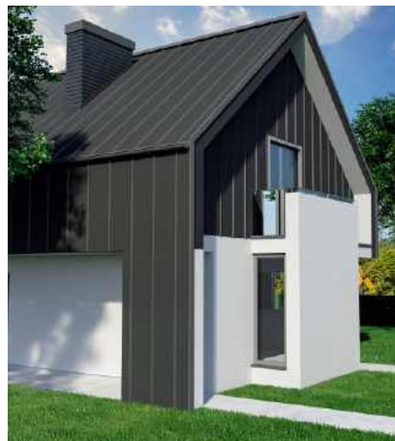
📍 Elewacja z pionowymi listwami z bruzdami w kształcie rąbka. Efekt imitacji blaszanego pokrycia jest najlepszy, gdy kolor tynku i farby, którą maluje się listwy, jest taki sam. BELLA PLAST
