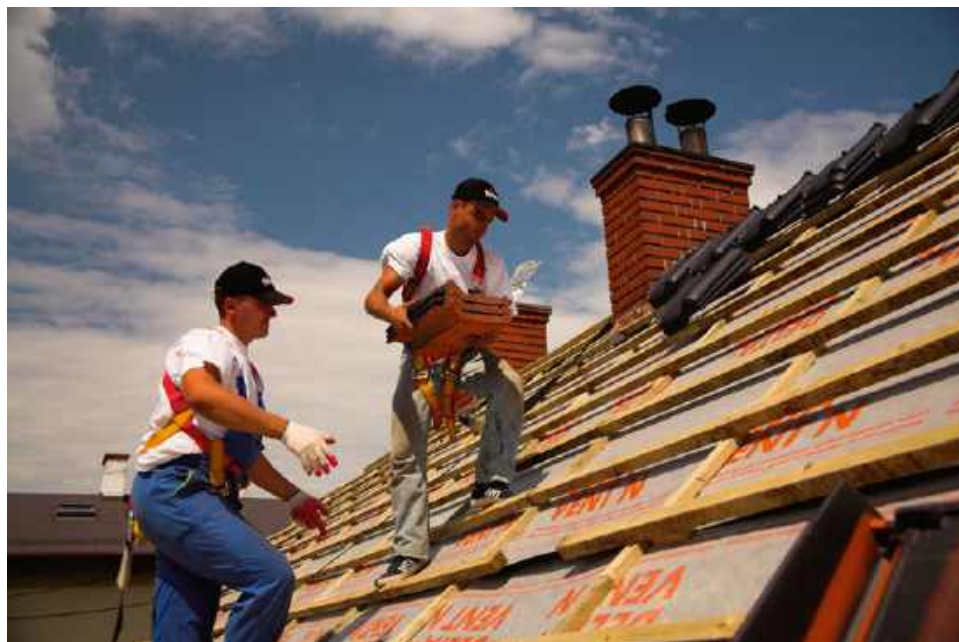
🔗 Nadmierna wilgotność drewna jest problemem nie tylko w przypadku masywnych elementów więźby. Również mokre łaty mogą się odkształcić na tyle, że będzie to potem widać na powierzchni ułożonego pokrycia. RÖBEN
