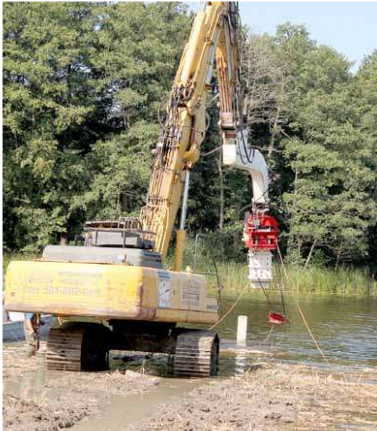
Żelbetonowe pale wbijane są na głębokość kilku metrów w dno jeziora
