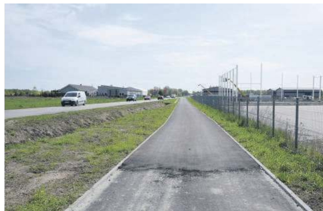
Na odcinku 1 km ciągu pieszo-rowerowego łączącego gminę Wisznia Mała z Obornikami Śląskimi i Wrocławiem ułożono już nawierzchnię bitumiczną
