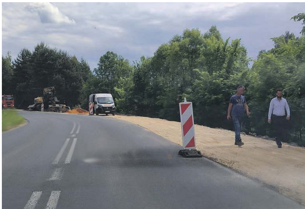
Budowa trasy pieszo-rowerowej wzdłuż Trzebińskiej w Pile Kościeleckiej
