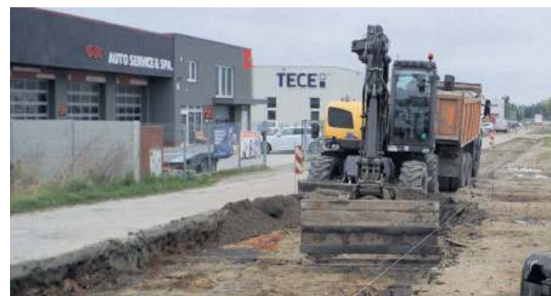
Prace na ulicy Energetyków rozpoczęto od rozbiórki betonowych elementów starej drogi. Foto: UMiG
