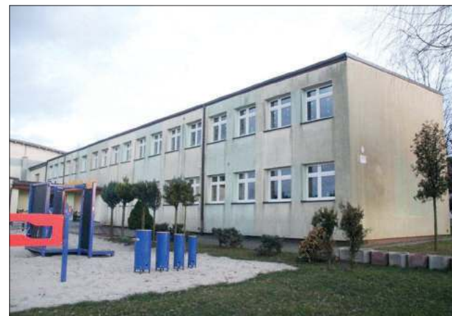
Rudnik. To część szkoły, która ma zostać rozbudowana.
