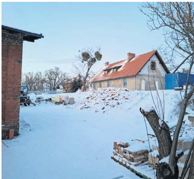
Dom rakarzy widoczny od strony podwórza. Tu trwają obecnie prace wykończeniowe
