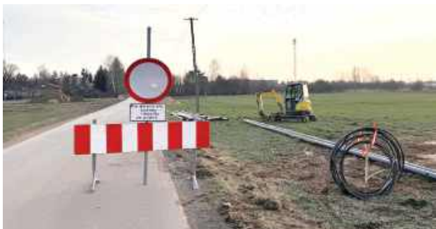
Ruszyła budowa trasy S19, obwodnic Niemiec i Lubartowa
